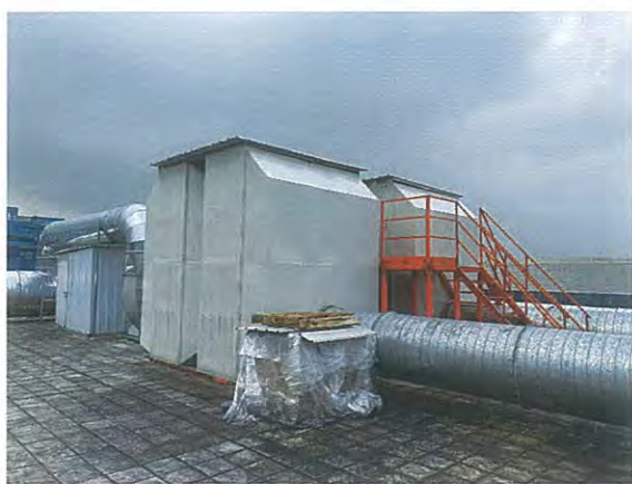
图 5-2a 废气处理设备（两级活性炭）
